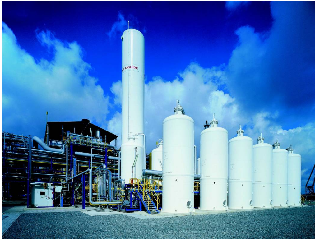
Figure 5 : unité de production d'hydrogène à Anvers (PSA à 12 bouteilles)
